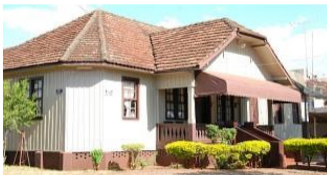
Hotel Rolândia, antes de ser demolido
