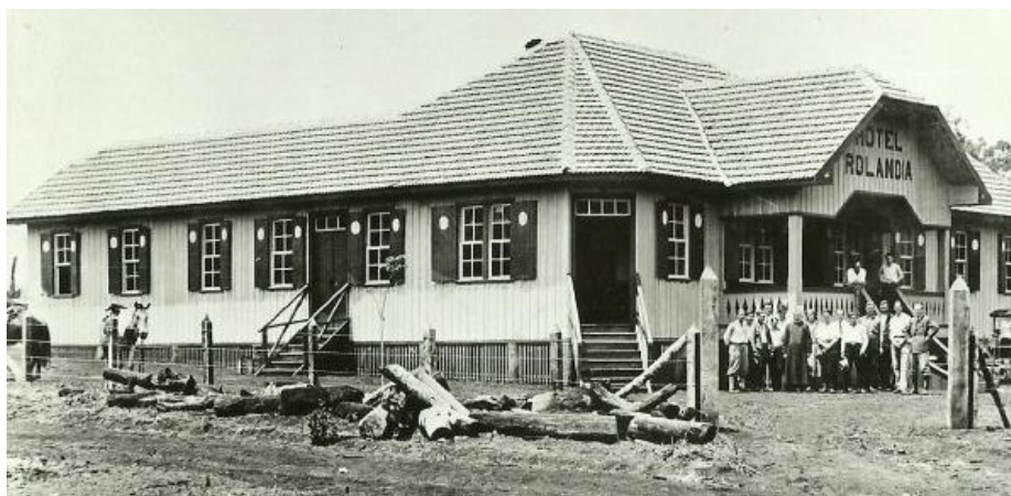
Em 1934, quando estava sendo construído
